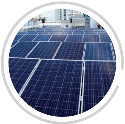
**Sistema de energía solar:** 118 paneles solares de 250W instalados en la azotea del MMG Tower, sede e ícono de sostenibilidad ambiental de Morgan & Morgan.
